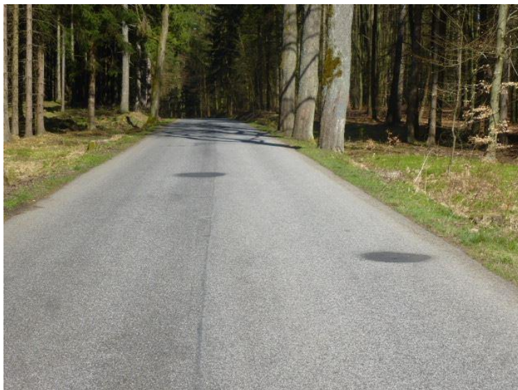
4. II/265 - Brtníky – Staré Hrabčcí
