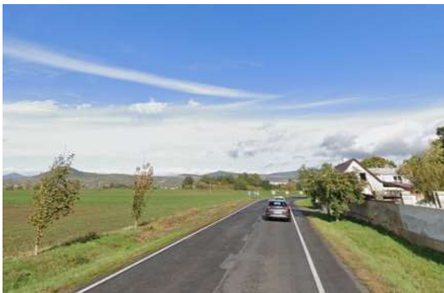
22. III/2474 Bohušovice nad Ohří – protismyková úprava
